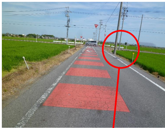
＜従道路…小垣江方面から見る＞
